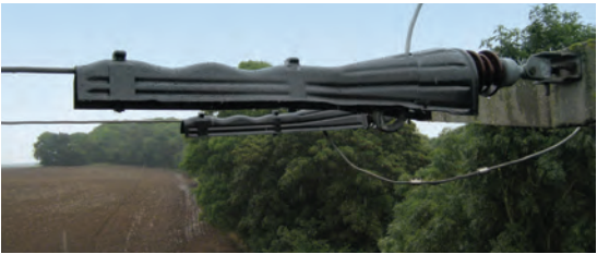
BCIC-TEN-01: Установка на натяжной изолятор
