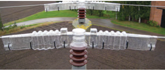
BCIC-1217-TR: Установка на опорные изоляторы
